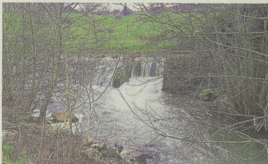
Au moulin de la Mécanique, une rivière de 50 m contournera le barrage et le déversoir sera abaissé d'un mètre.
