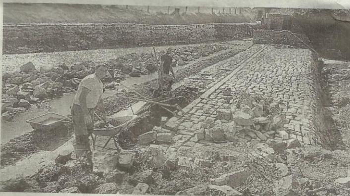
Les travaux sur l'ouvrage de la Mécanique seront terminés fin octobre.
