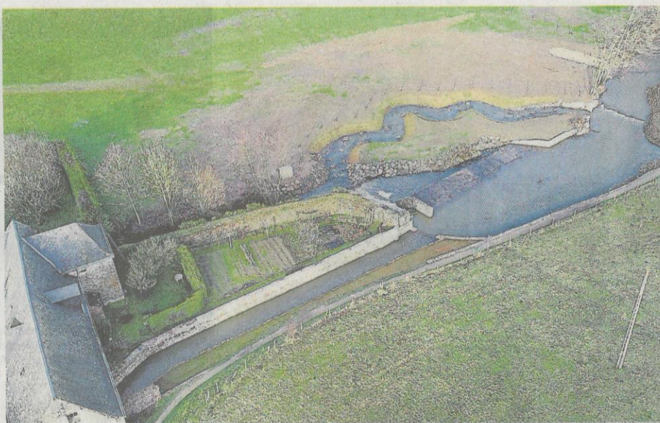
Une vue d'ensemble du Moulin de la Mécanique après sa mise en conformité.
