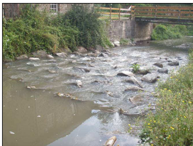
Rampe en enrochements au Grand-Moulin
