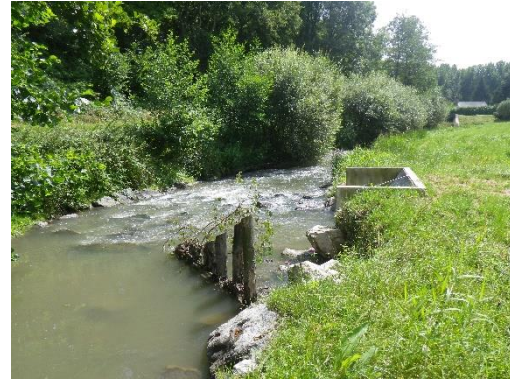
Prise d'eau installée en 2014
