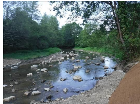
Amont ouvrages démantelés - juillet 2018
