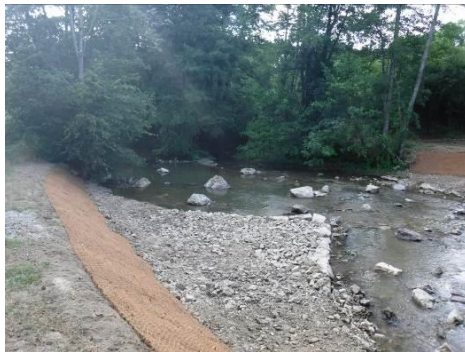
Ouvrages démantelés - juillet 2018
